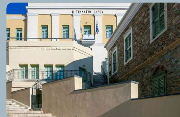
Κτίριο πρώην Α' Γυμνασίου, Τμήμα Μηχανικών Σχεδίασης Προϊόντων & Συστημάτων, Ερμούπολη Σύρου
